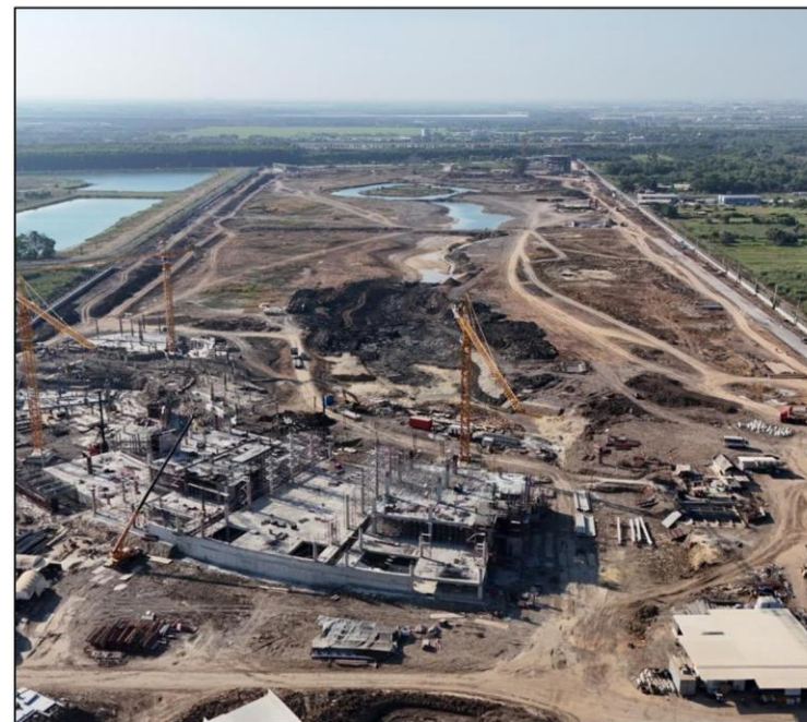
งานก่อสร้างอาคารต้อนรับ อาคารศูนย์การเรียนรู้ และบริเวณ Zoo Zone
