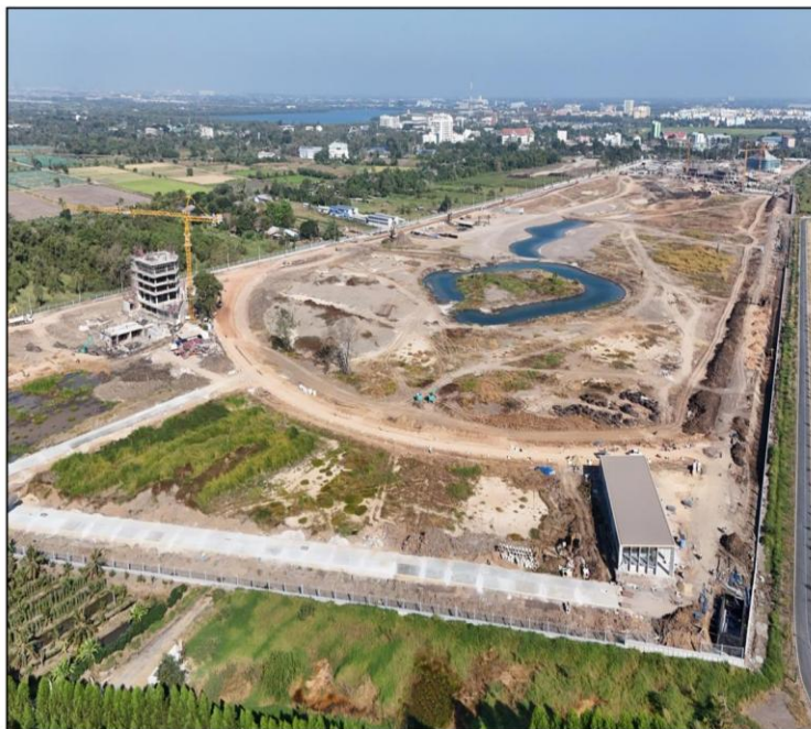
งานก่อสร้างอาคารสำนักงานใหญ่/อาคารคลัง อาหารสัตว์ และอาคารจตุรวิทยะ/แยกขยะ
