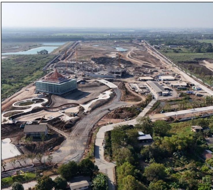
งานก่อสร้างโซนเฉลิมพระเกียรติ และอาคารเฉลิมพระเกียรติ
