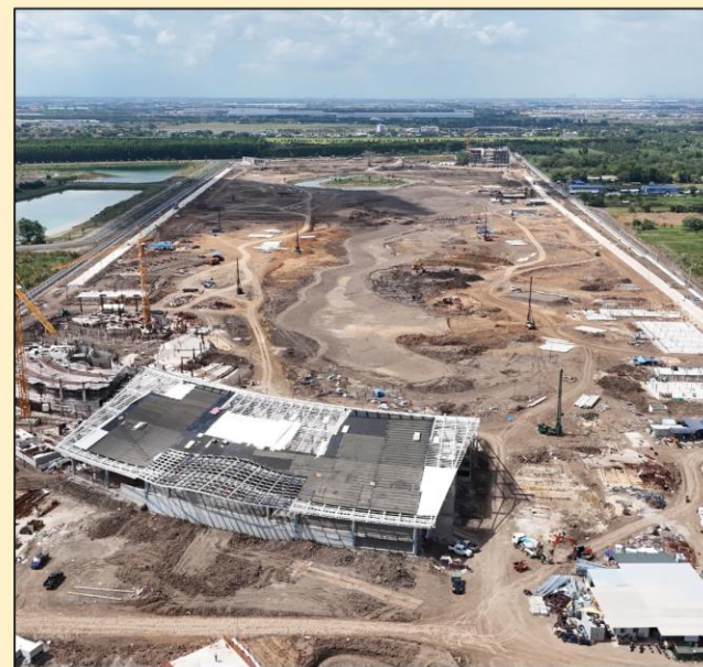
งานก่อสร้างอาคารต้อนรับ อาคารศูนย์การเรียนรู้ และบริเวณ Zoo Zone
