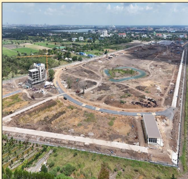
งานก่อสร้างอาคารสำนักงานใหญ่/ อาคารคลังอาหารสัตว์ และอาคารจุกดูรายชยะ/แยกขยะ
